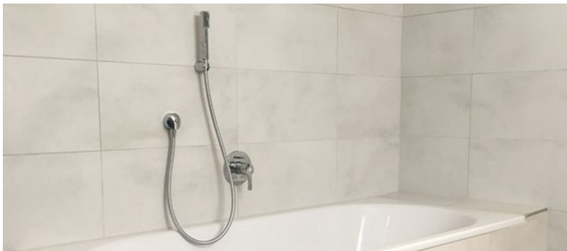
Beispielhafte Darstellung Badewanne mit Unterputz-Armatur
